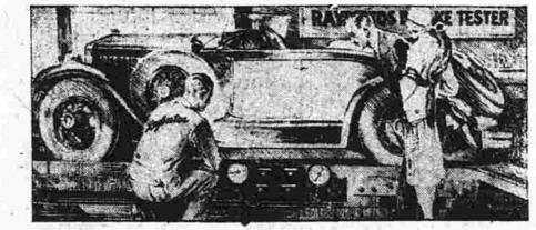
RAYBESTOS BRAKE TESTING MACHINE
